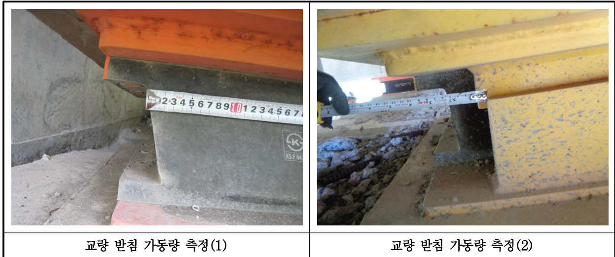
【사진 34.3.40】 교량받침 이동량 측정
