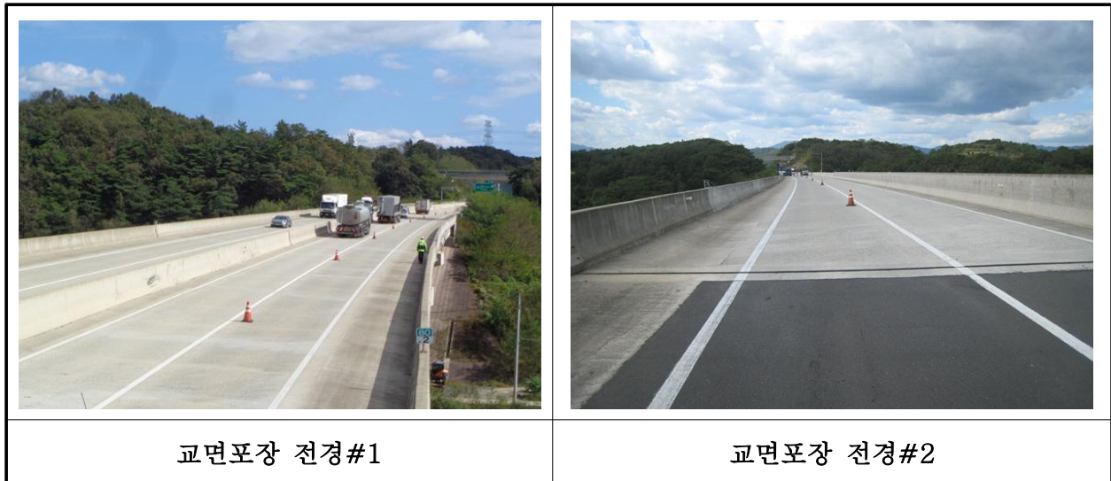
【사진 34.3.44】 교면포장 전경
