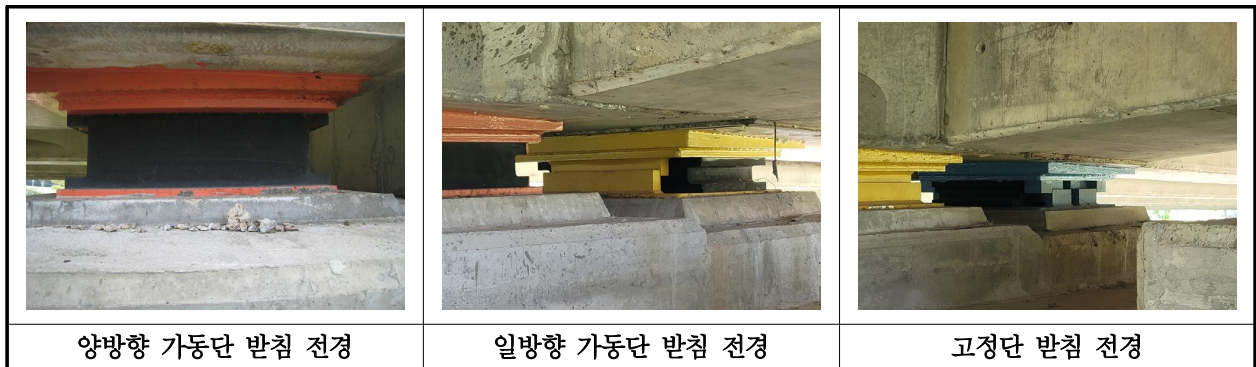
【사진 34.3.12】 교량받침 전경
