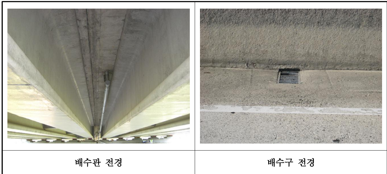
【사진 34.3.21】 배수시설 전경
