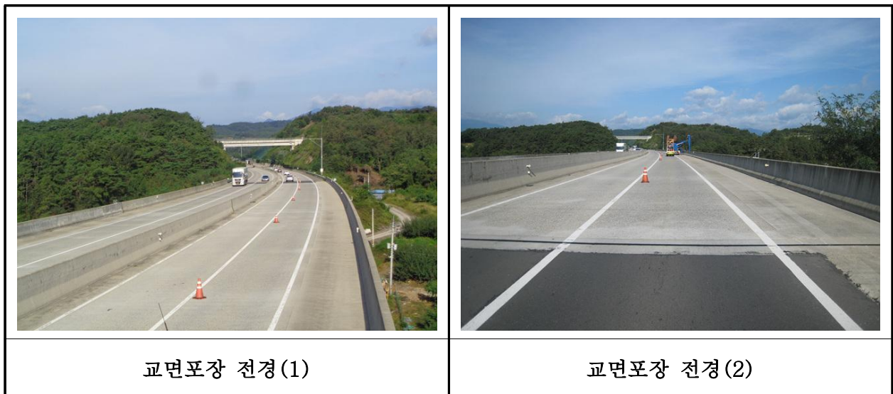
【사진 34.3.19】 교면포장 전경
