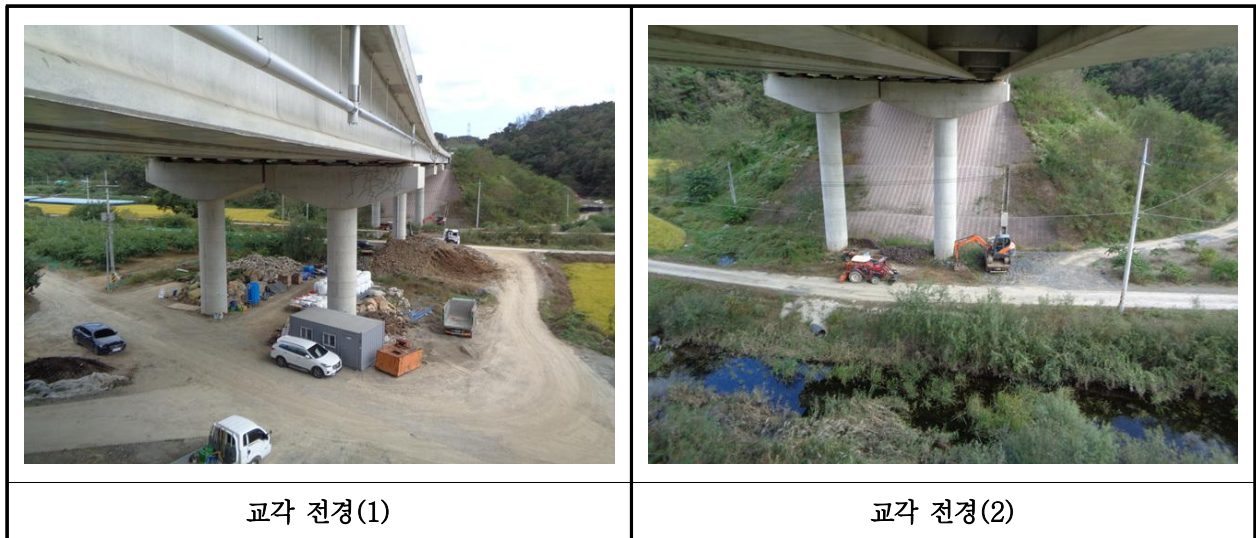
【사진 34.3.35】 교각 전경
