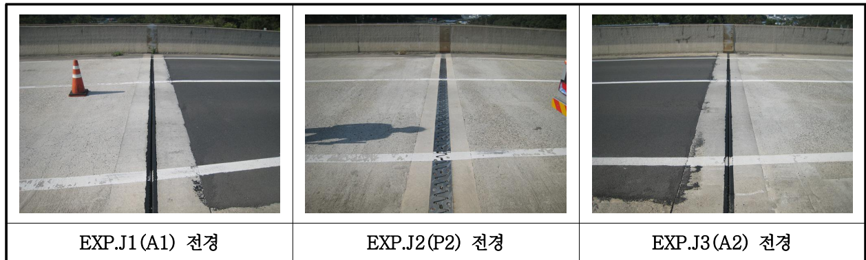
【사진 34.3.16】 신축이음장치 전경
