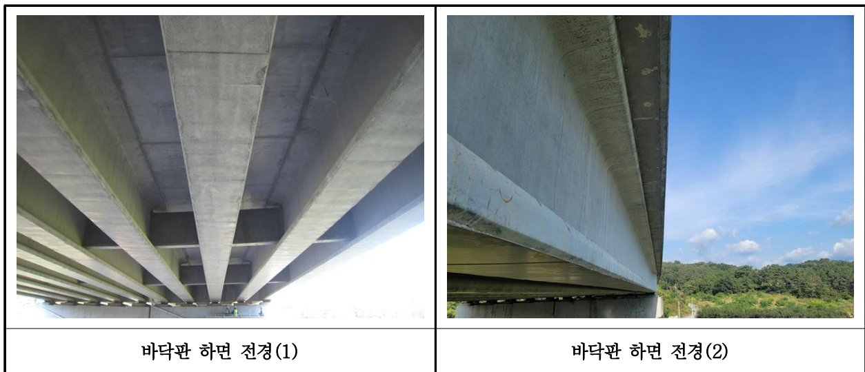
【사진 34.3.2】 바닥판하면 전경
