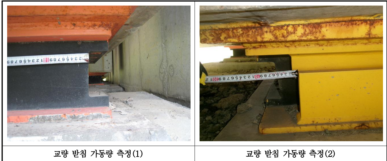
【사진 34.3.15】 교량받침 이동량 측정
