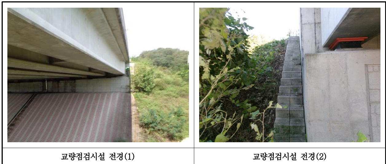
【사진 34.3.25】 교량 점검시설 전경
