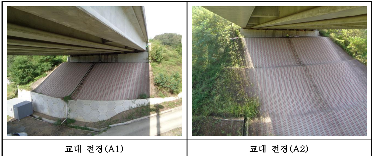
【사진 34.3.8】 교대 전경
