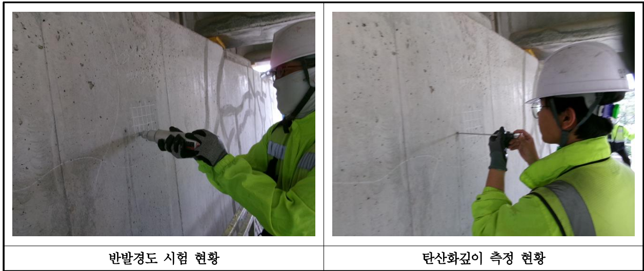
【사진 34.4.1】 콘크리트 내구성조사 현황
