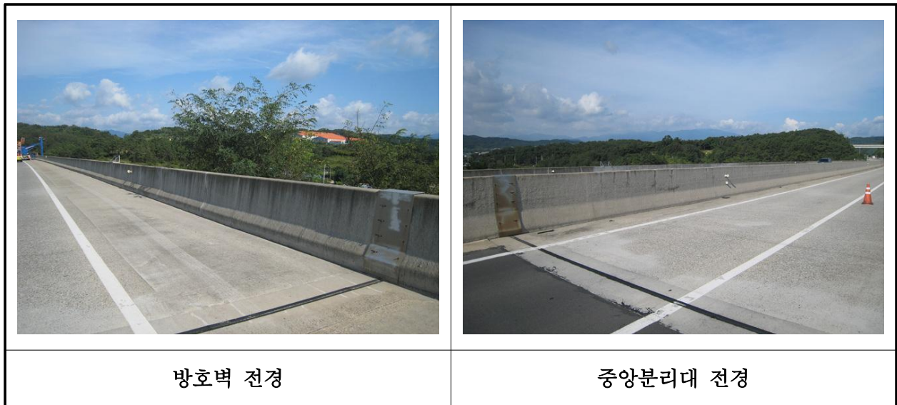
【사진 34.3.23】 방호벽 및 중앙분리대 전경
