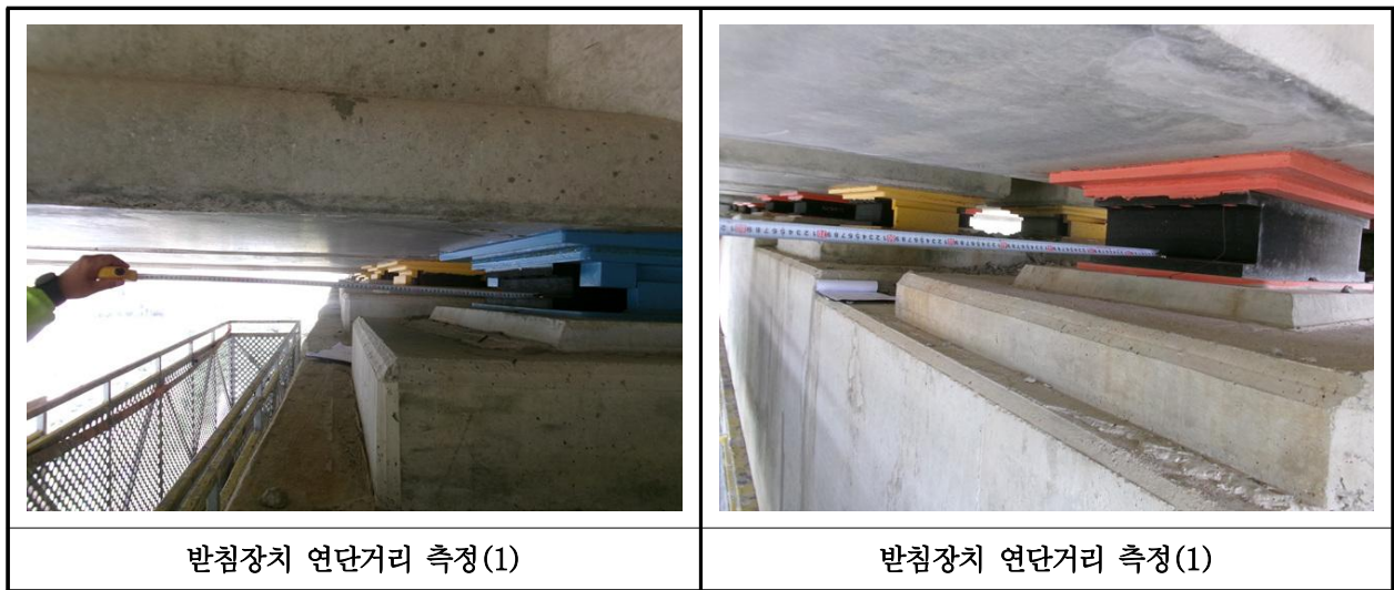
【사진 34.3.39】 교량받침장치 연단거리측정
