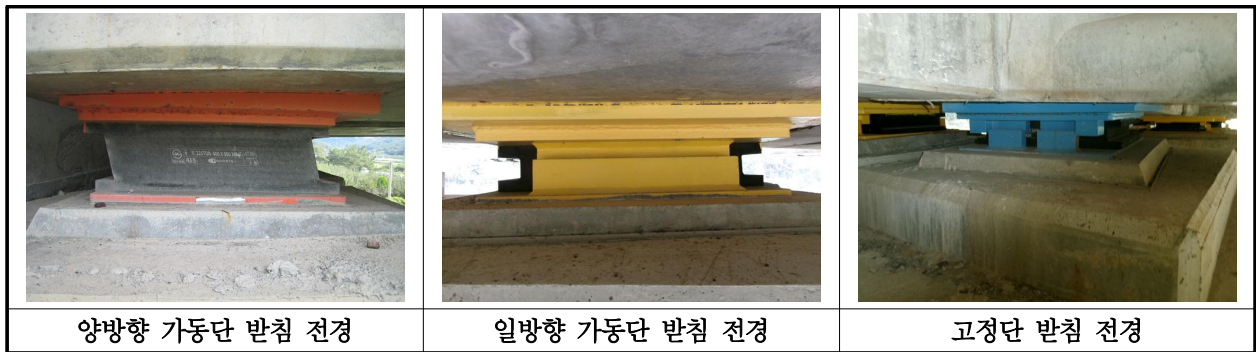
【사진 34.3.37】 교량받침 전경
