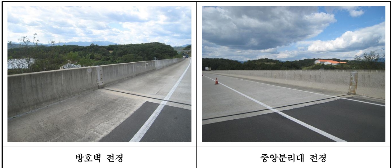
【사진 34.3.48】 방호벽 및 중앙분리대 전경
